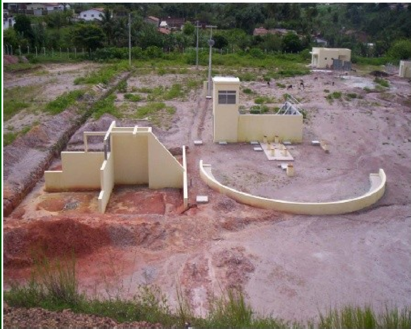
Foto 24 Unidade de Triagem e Beneficiamento sem Equipamentos
