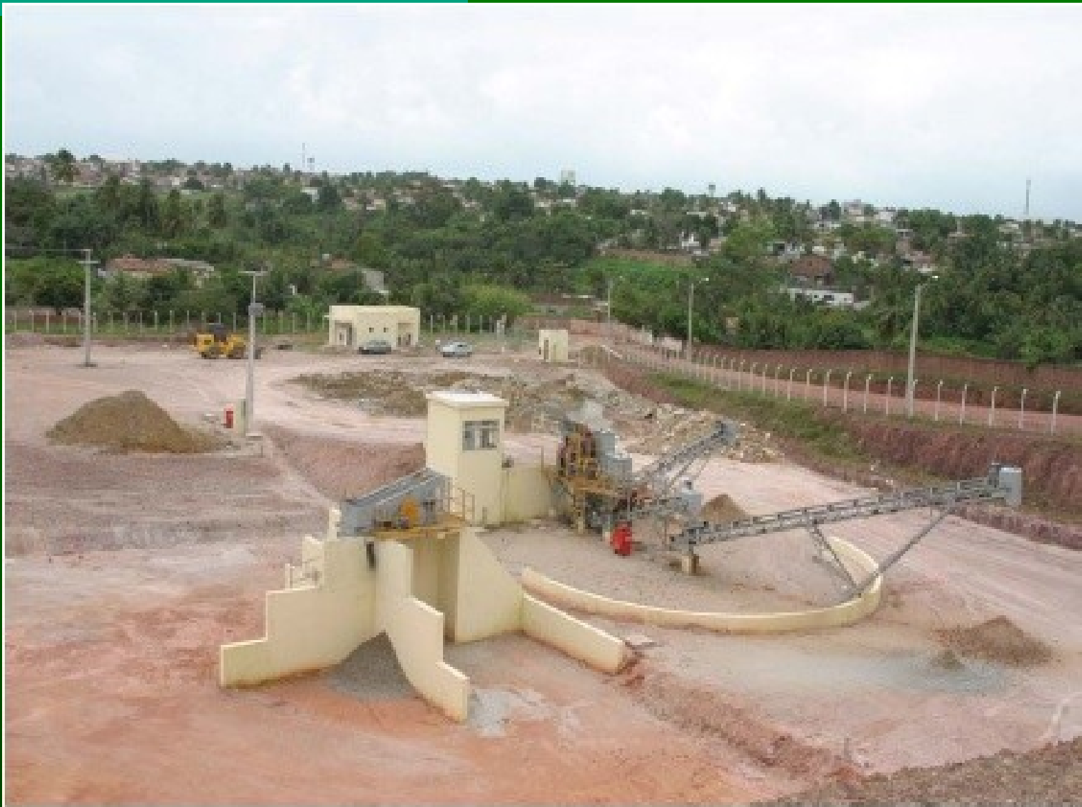
Foto 25 -Unidade de Triagem e Beneficiamento do RCD Concluída
