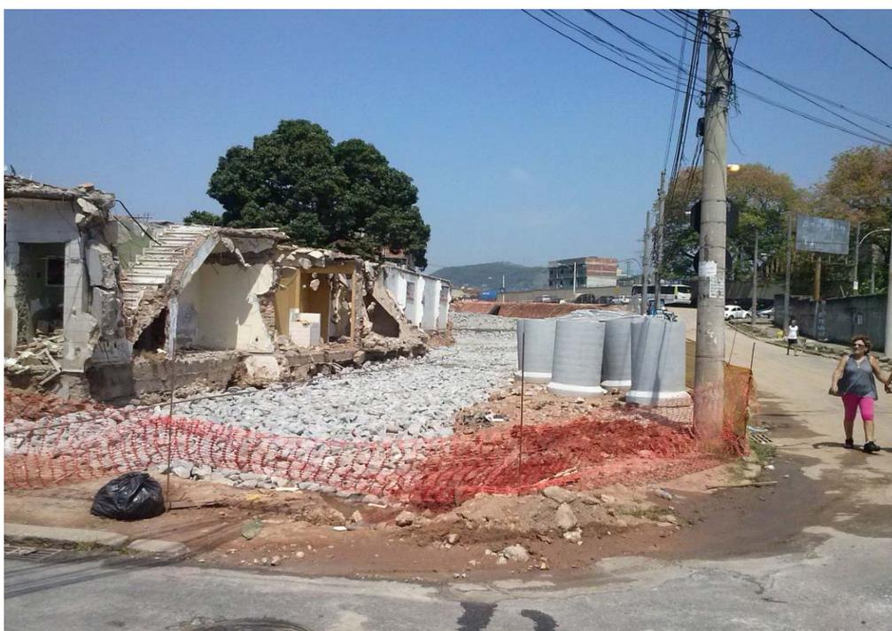
**Figura 3.** Reutilização de resíduos de construção e demolição na pavimentação da Avenida Vicente de Carvalho - RJ (Foto: Souza, 2013)
