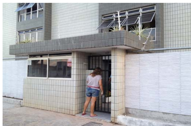
Figura 3. Fachada Frontal da Guarita 02 (Voltada para o Norte com cobertura vegetal).
