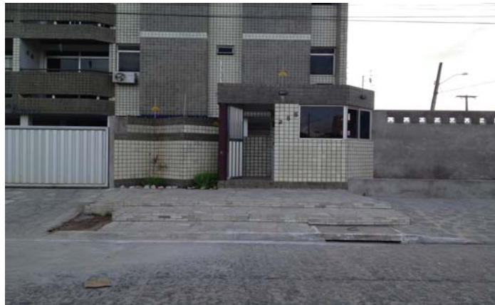
Figura 4. Fachada Frontal da Guarita 03 (Voltada para o Leste com laje impermeável).
