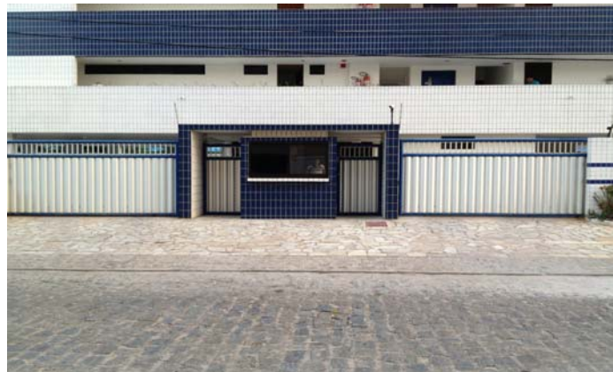
Figura 2. Fachada frontal da Guarita 01 (Voltada para o Norte com laje impermeável).
