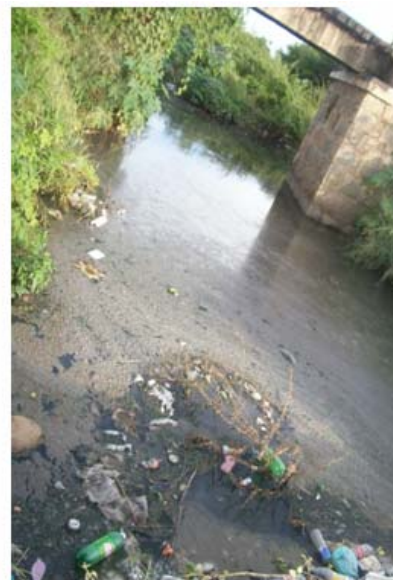
Figura 2a: Um dos encontros final de lançamento do esgoto com o Rio - Pombal/PB (2013)
