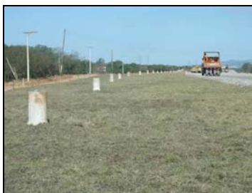
Foto 11. Vista geral da célula antes do cercamento.
