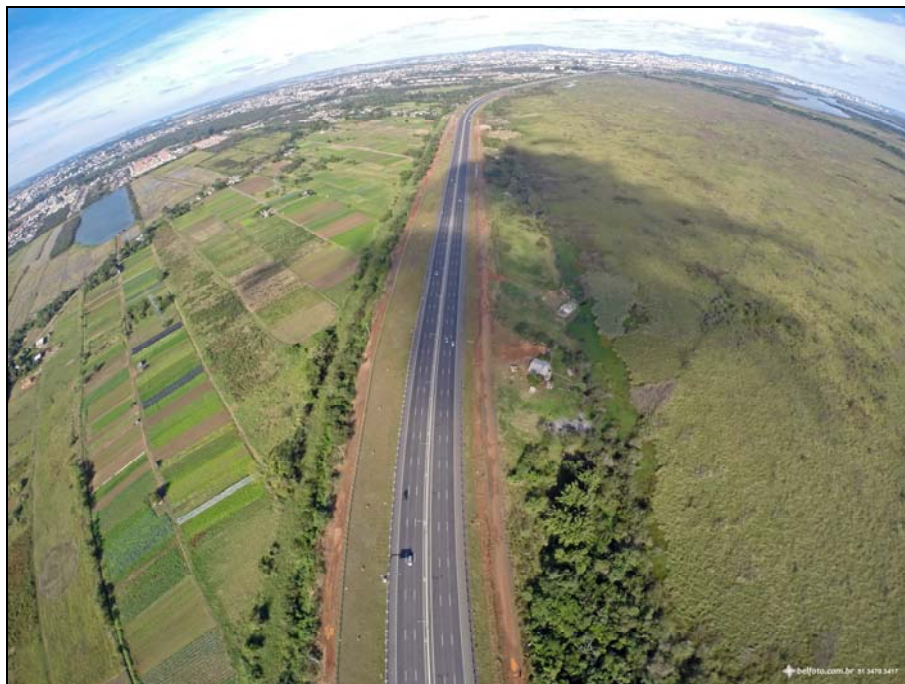
Foto 13. Célula 02 após execução da cobertura final. Lado esquerdo da Rodovia BR-448. Fonte: Autores do trabalho
