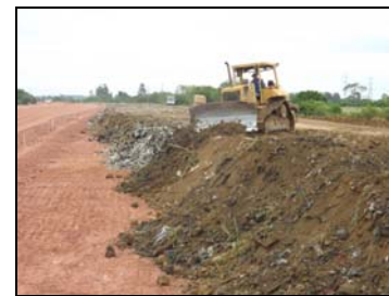
Foto 3. Adensamento dos resíduos com trator esteira.
