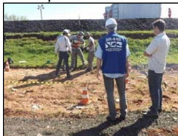
Foto 15. Perfuração do poço de monitoramento P2J.
