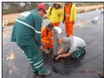
Foto 7. Instalação dos drenos de gás.
