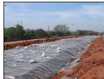
Foto 6. Instalação da geomembrana de PEAD.
