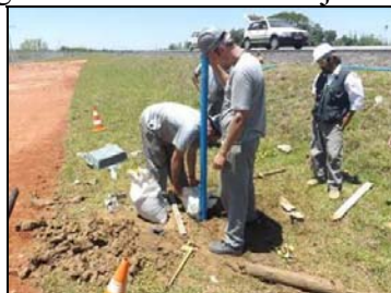
Foto 14. Instalação do poço de monitoramento P1M.
