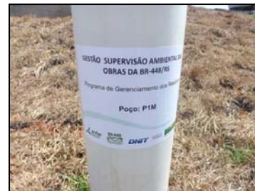
Foto 16. Poço P1M após instalação.
