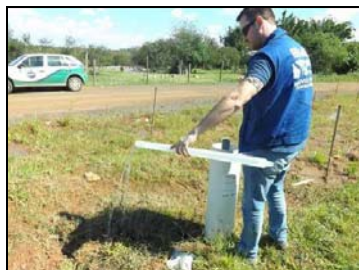
Foto 17. Esgotamento dos Poços.
