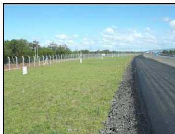
Foto 10. Célula após execução da cobertura final.
