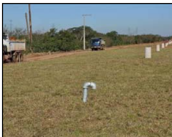
Foto 8. Drenos instalados.
