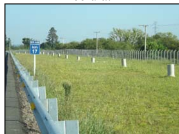
Foto 12. Vista geral da célula após cercamento.
