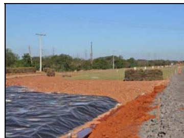
Foto 9. Componentes da cobertura final da célula.
