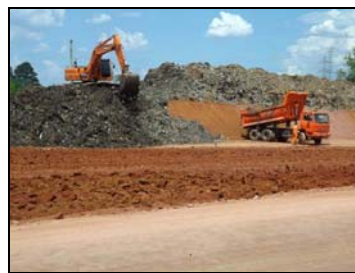
Foto 2. Disposição dos resíduos na célula.
