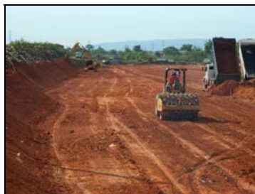
Foto 1. Compactação da base da célula.
