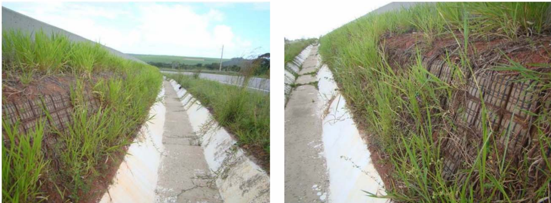
Figura 2. Aplicação de gramíneas por hidrossemeadura e construção de drenagem central para prevenir processos erosivos próximos ao Rio Baldum, trecho RN.
