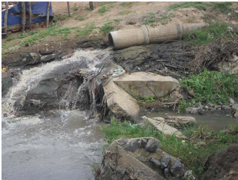
Figura 2. Ponto de lançamento de esgoto no bairro Rio Verde
