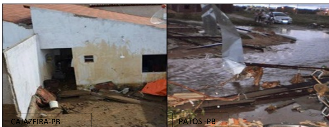
Figura 4. Desmoronamento de habitações e destroços levados pela força da água, chuvas de 2014.
