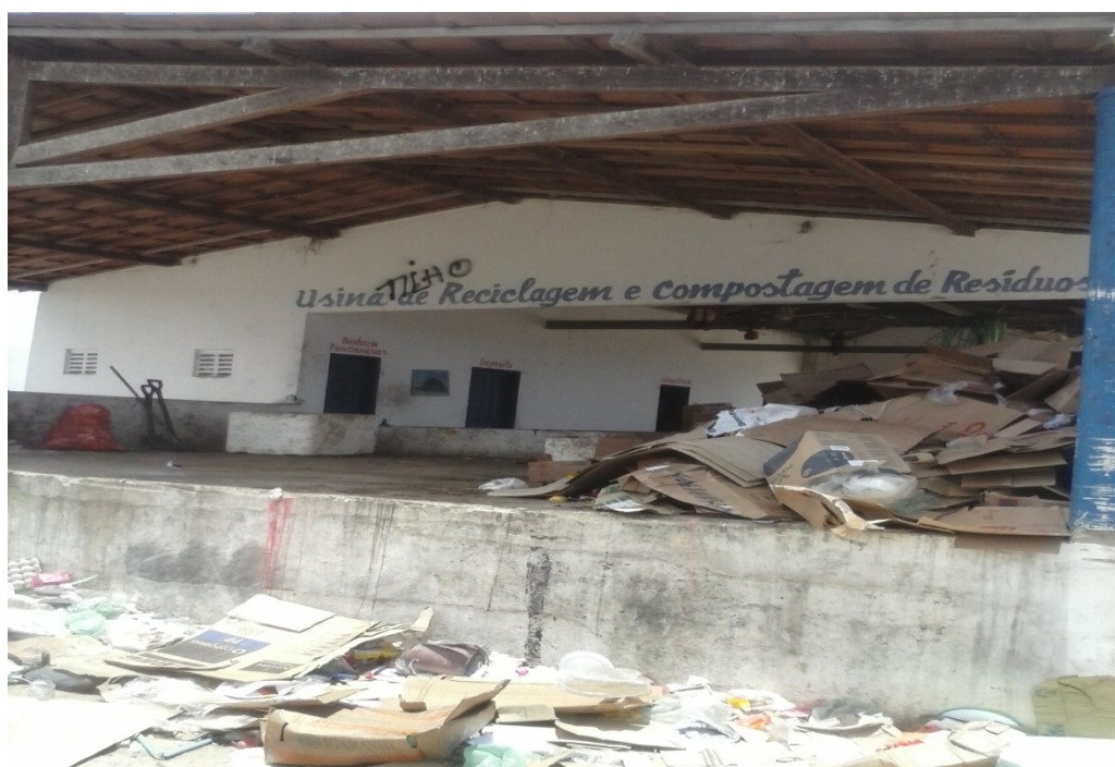
Figura 5. Usina de reciclagem e compostagem de resíduos sólidos localizada no lixão de Araruna-PB, vista frontal.
