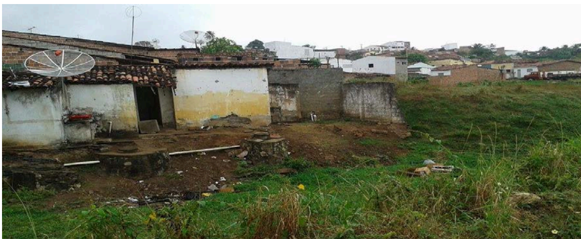
Figura 10. Residências próximas a um rio, local de deposição de resíduos de construção e demolição (RCD) na cidade de Guarabira-PB, localizado nas intermediações do bairro nordeste I e nordeste II. Fonte: Dados da pesquisa, 2015.
