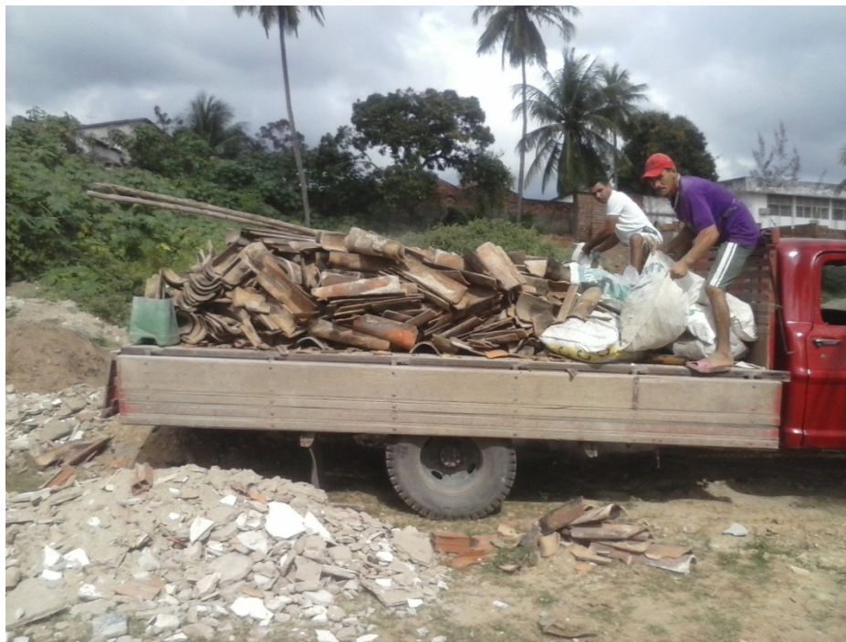
Figura 8. Caminhão despejando resíduos de construção e demolição (RCD) na cidade de Guarabira-PB, localizado nas intermediações do bairro nordeste I e nordeste II. Fonte: Dados da pesquisa, 2015.
