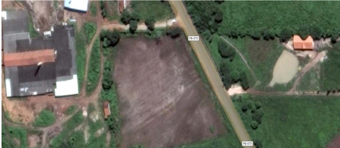
Figura 3. Imagem aérea do lixão da Cidade de Guarabira-PB, localizado às margens da PB-073, outro local de destino para os resíduos de construção e demolição (RCD). Fonte: Google Maps, 2015.
