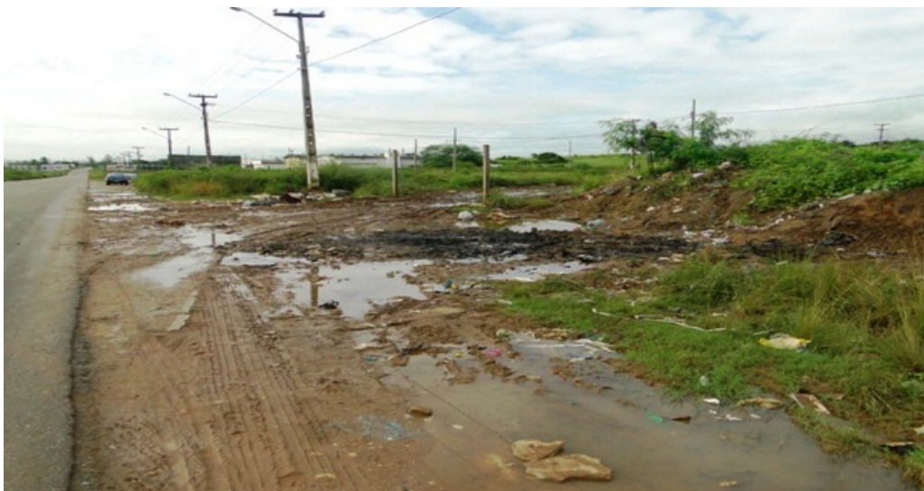
Figura 5. Lixão da Cidade de Guarabira-PB, localizado às margens da PB-073, outro local de destino para os resíduos de construção e demolição (RCD). Fonte: http://guarabira50graus.blogspot.com.br .
