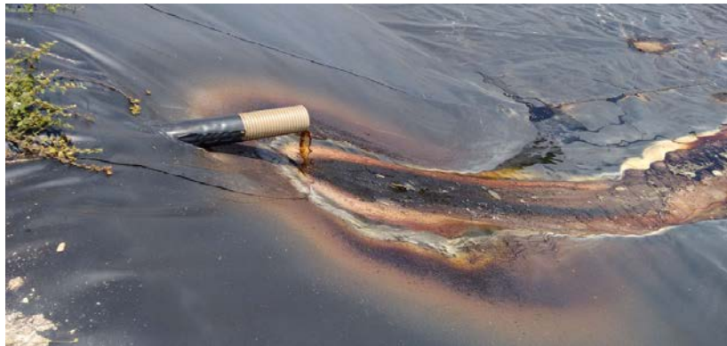
Figura 2. Entrada do chorume na lagoa de estabilização.
