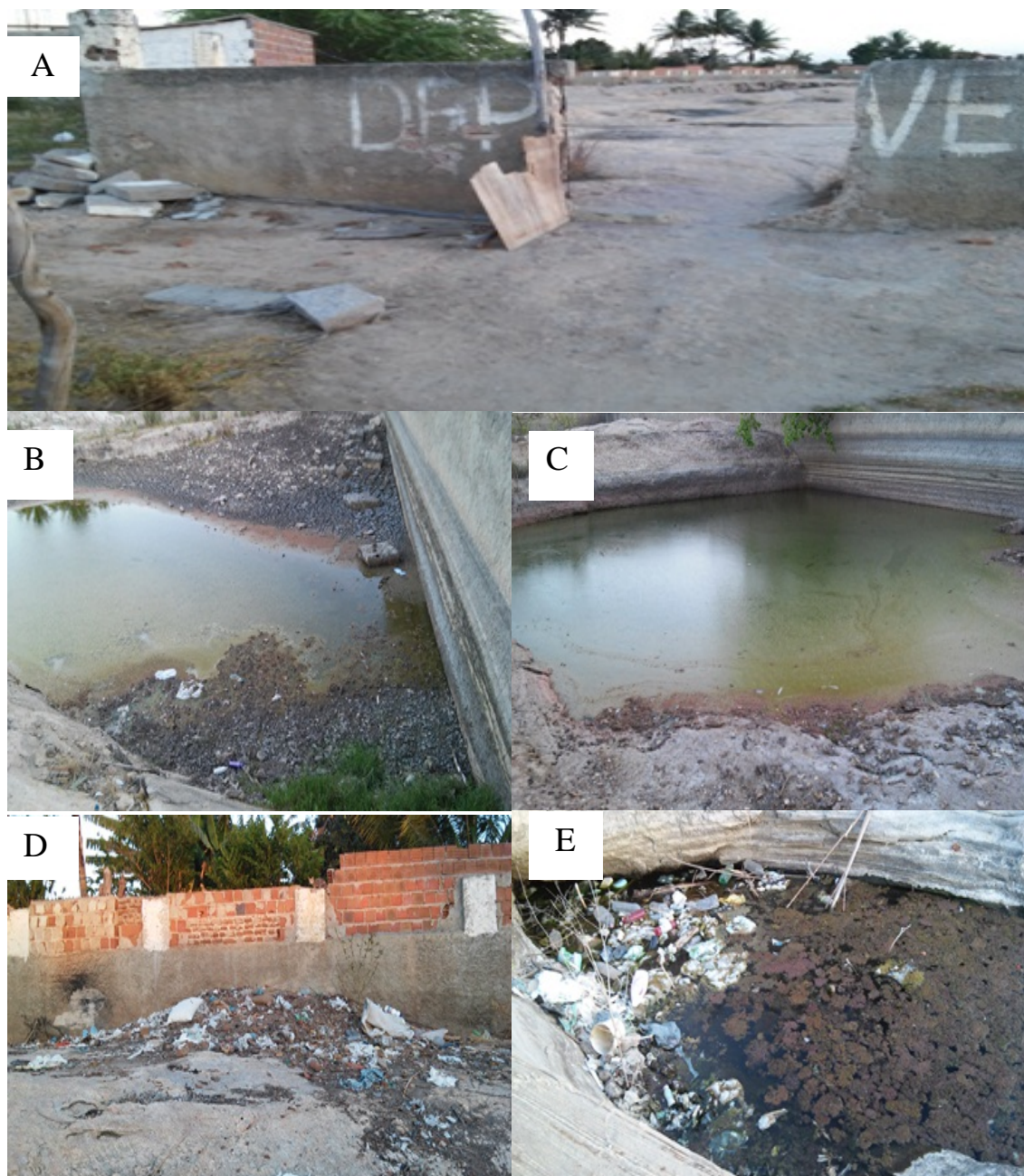
Figura 5. A - Vista frontal do Tanque Municipal de São Vicente do Seridó-PB. B – C. aglomeração de águas contaminadas, D – E; Acúmulo de resíduos sólidos.
