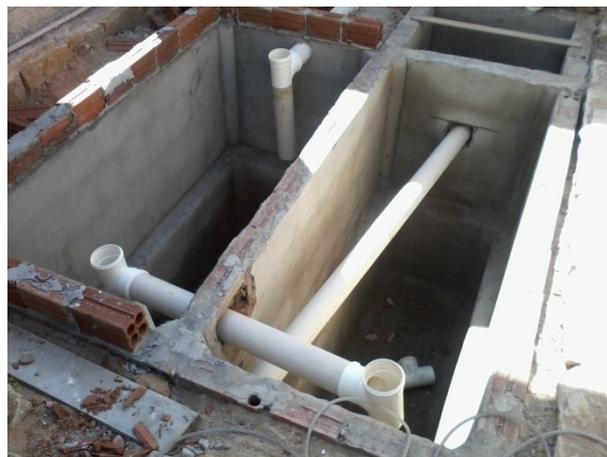
**Figura 6.** Fossa e filtro com clorador em fase de instalação.
