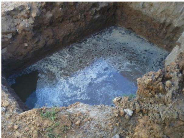
**Figura 1.** Escavação para instalação de uma fossa e sumidouro, água brotou do solo.
