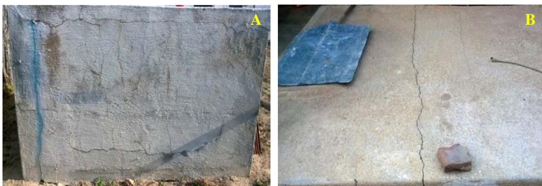
**Figura 3:** Rachaduras em reservatório de água proveniente das detonações realizadas pela pedreira no Município de Caraúbas-RN. (A) Parte lateral de uma cisterna atingida; (B) Parte superior de uma cisterna atingida.
