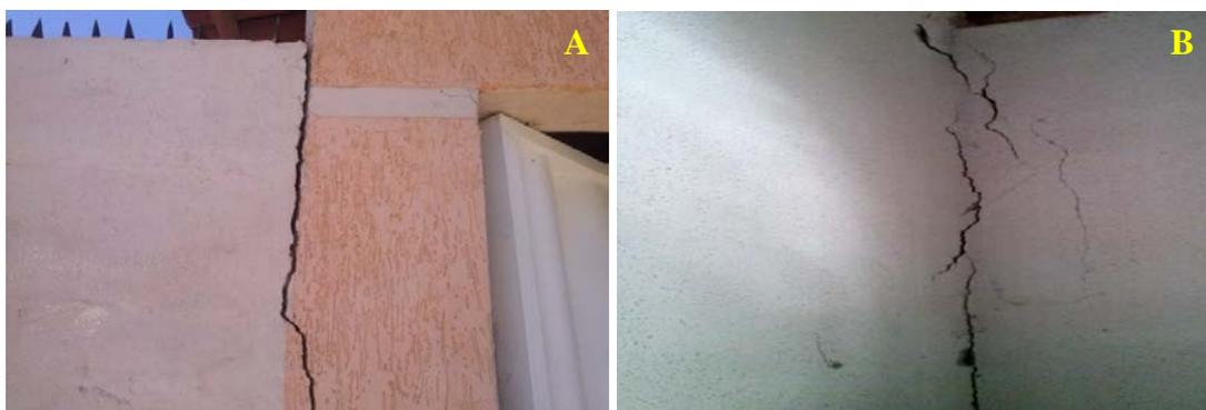
**Figura 2:** Rachaduras proveniente das detonações realizadas pela pedreira no Município de Caraúbas-RN. (A) Fachada de uma residência atingida; (B) Interior de uma residência atingida.
