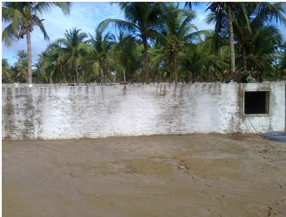
Figura 3. Local onde se concentra os reservatórios.
