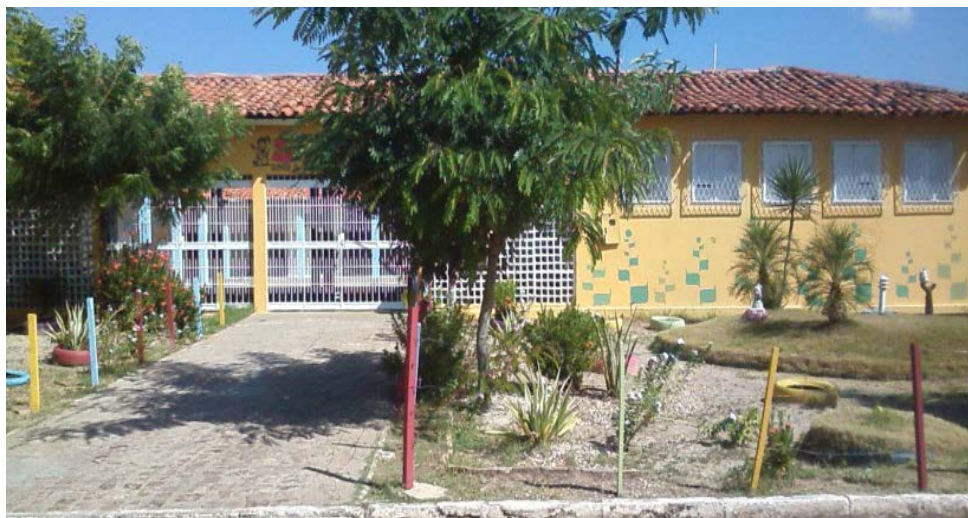
Figura 1. Prédio do SCFV em Campo Maior.
