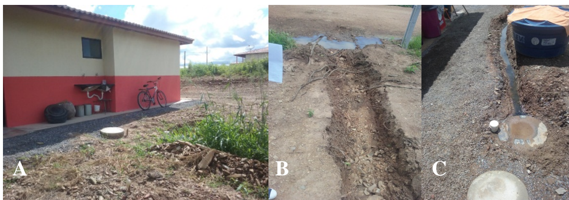
Figura 4 – fossas sépticas construídas muito próximas às casas
