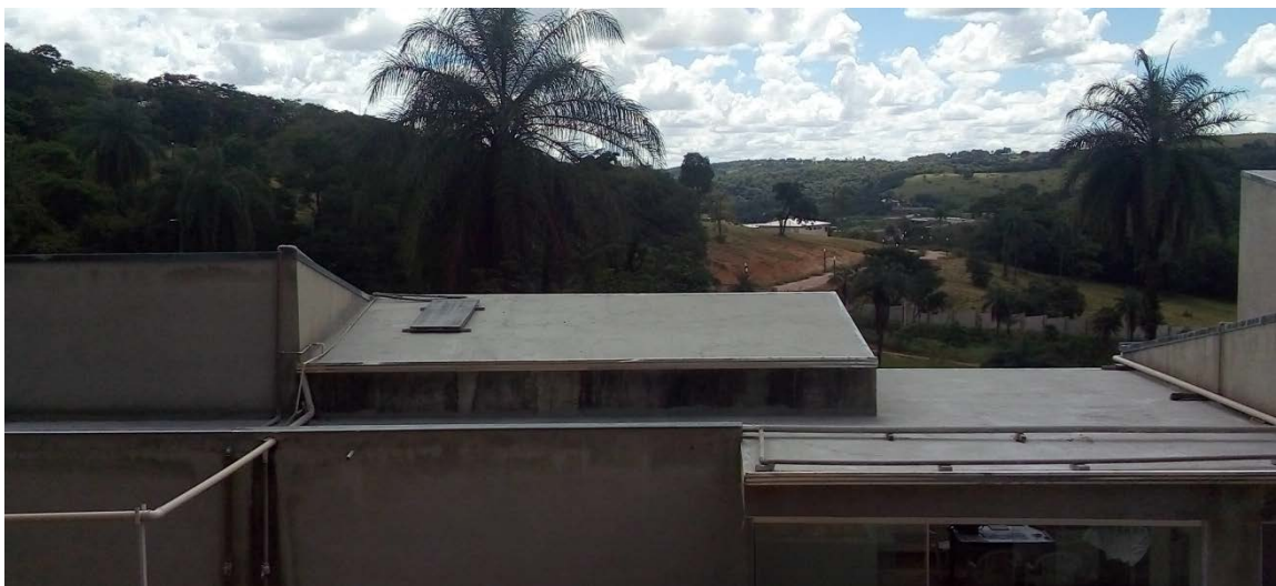
Figura 3- Placa fotovoltaica colocada no telhado
