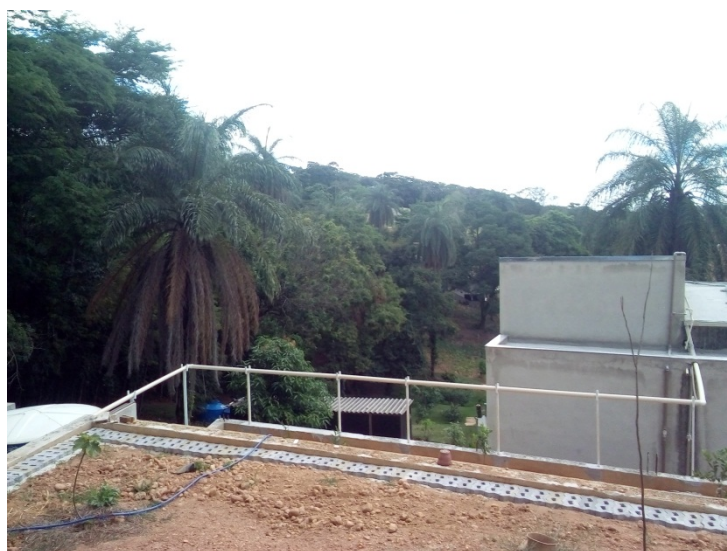
Figura 2: Tubulação ligada captando de água da cobertura
