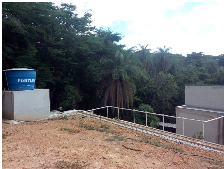
Figura 1: Caixa d'água ligada à captação de água da cobertura
