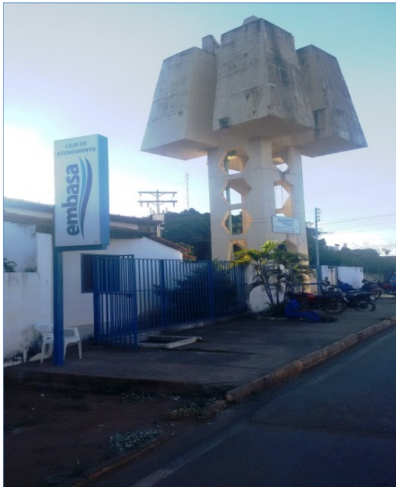
Figura 4. Reservatório, Bairro Centro e Projeto. Embasa, 2016.
