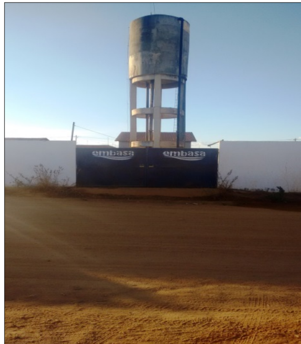
Figura 5. Reservatório, Bairro Santa Helena. Embasa, 2016.
