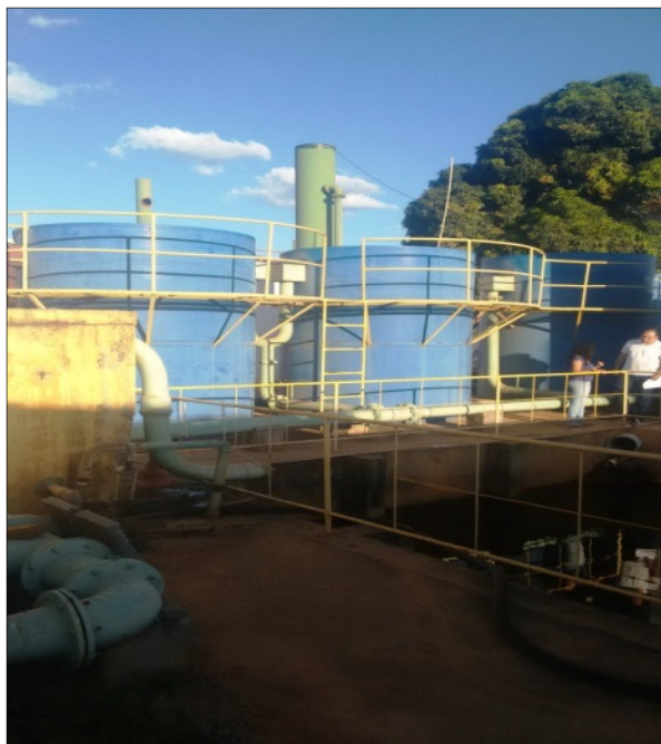
Figura 2: Sistema de Filtração Russa. Embasa, 2016.
