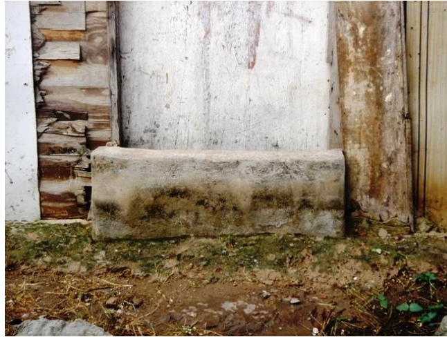
Figura 2 – Presença de dispositivos de proteção de portas nas residências localizadas próximas ao rio Jaguaribe, bairro São José. Fevereiro de 2016.
