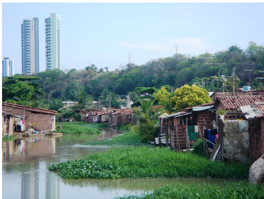
Figura 3 – Favela São José ocupação do leito do rio Jaguaribe, área de risco para mais de 1.300 famílias. Fevereiro de 2016.
