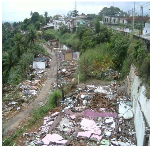
Figura 5 – Casas demolidas na área de risco mais crítica da comunidade Saturnino de Brito para o início das obras de contenção em 2013. Fonte: SEMHAB/PMJP.
