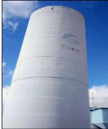
Figura 2: Câmara de carga reguladora de pressão.
