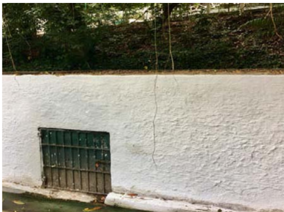
Imagem 1 – Cisterna de canalização da água da Fonte Tambiá.
