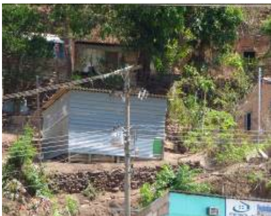
Figura 11 – Edificação com materiais improvisados Fonte: Foto da primeira autora (2015).
