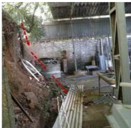
Figura 4 - Movimento de terra ao fundo de uma edificação comercial Fonte: Colturato (2013).
