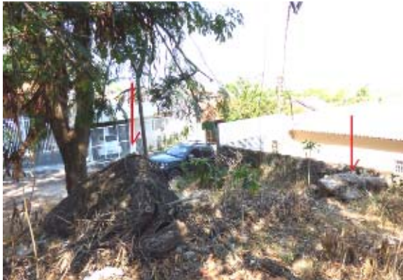
Figura 6 – Blocos rochosos desprendidos no bairro Jardim Amazônia. Fonte: Foto da primeira autora (2015).
