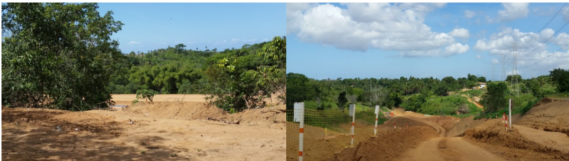
Figura 5 - Áreas sem vegetação, trecho das obras da via expressa no município de Lauro de Freitas, Bahia.
