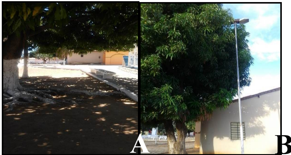
Figura 2 - Raízes danificando a calçada (A); Conflito com poste de iluminação (B). Pesquisa de campo, 2016.
