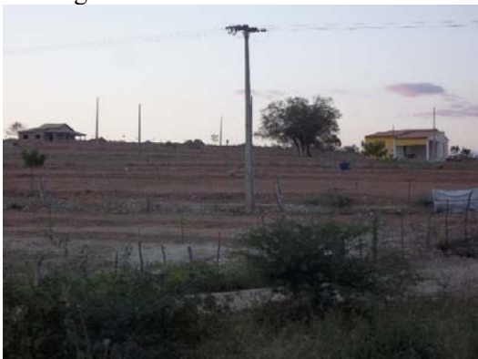
Figura 7. Casas e instalações elétricas próximas às margens do rio.
