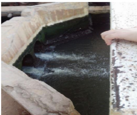
Esgotos Clandestinos – Rio Sanhauá
