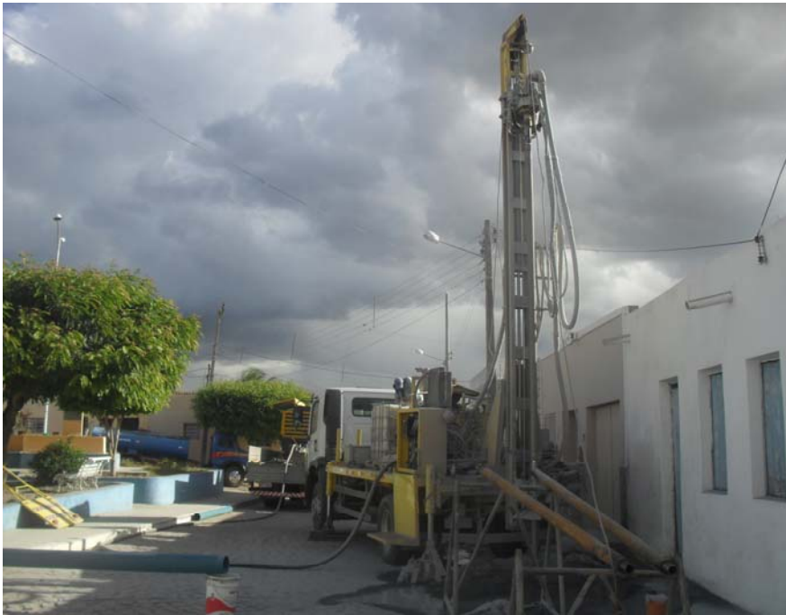
Figura 5 – Perfuração de poço artesiano na Praça Dona Maria Aurora Diniz.
