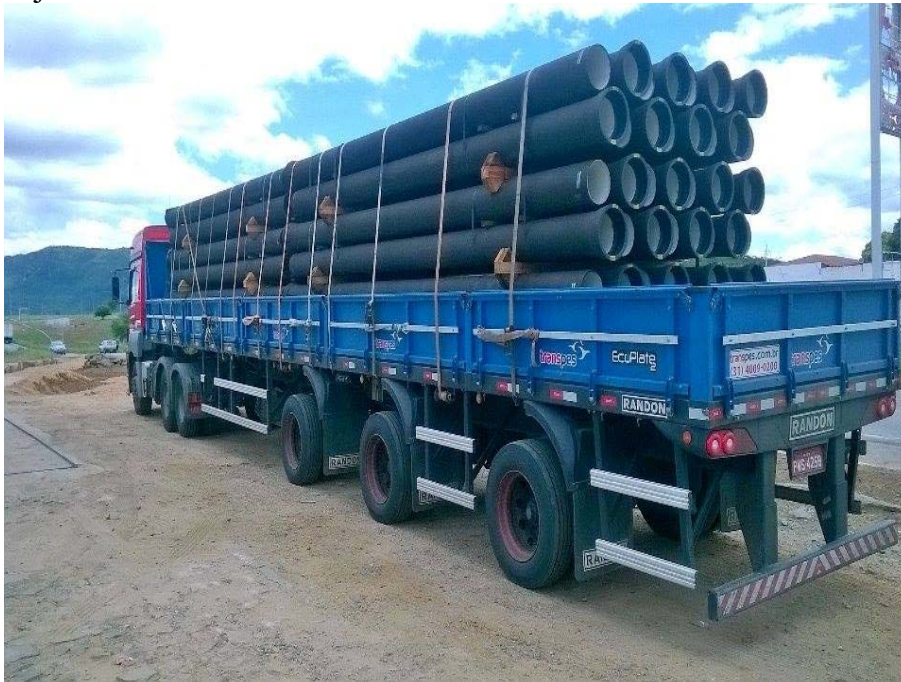
Figura 3 – Canos para a construção da transposição do Rio São Francisco, adutora do Pajeú ramal Princesa Isabel.
