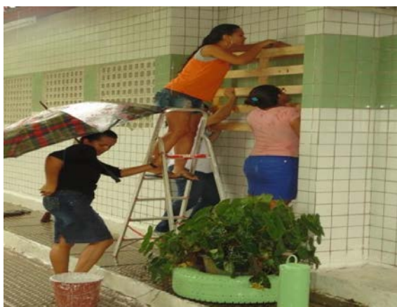
Foto 05. Aplicação do pallet para o jardim suspenso. Fonte: Autoria da equipe, Ano 2015.
