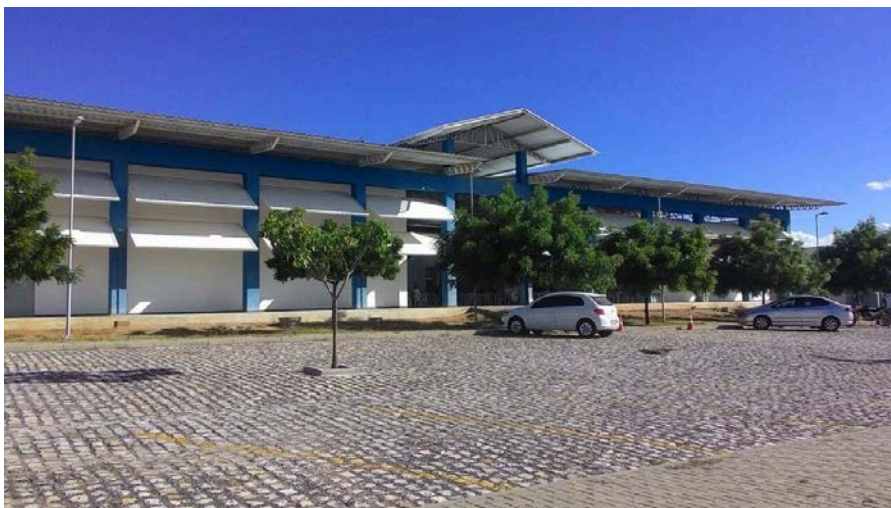
Figura 53 – Prédio do centro de convivência da UFERSA – Caraúbas.
