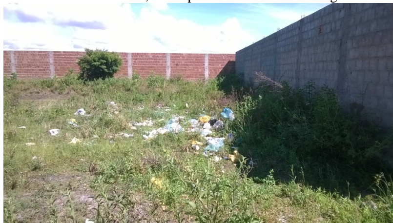
Figura 1. Muro em construção que separa o condomínio Lagos do Francês do povoado Cabreiras. Fonte: Os autores.
