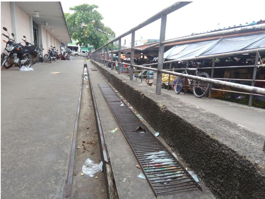
**Figura 8.** Boca de lobo sem a grelha metálica. Fonte: Autores, 2017.
