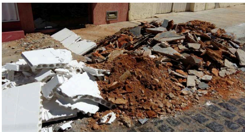
Figura 4. Disposição irregular de RCD nas ruas do município de Caraúbas-RN. Fonte: Autor.
