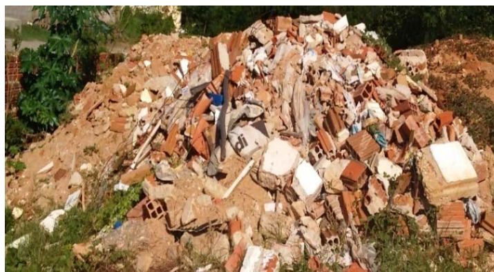
Figura 2. Resíduos acumulados em obra. Fonte: Autor.
