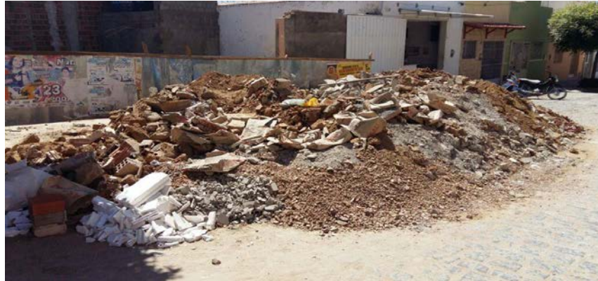
Figura 5. Disposição irregular de RCD nas ruas do município de Caraúbas-RN. Fonte: Autor.
