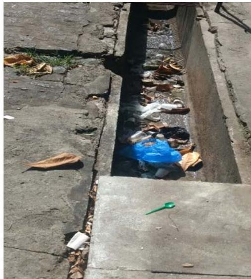
**Figura 9.** Depósito de resíduos no esgoto.
