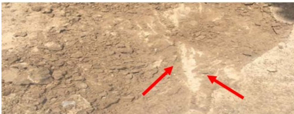
Figura 11. Compactação do solo da área estudada Fonte: AUTORES (2015).
