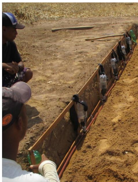
**Figura 2b.** Sistema sendo instalado no solo, para cultivo de mandioca.
