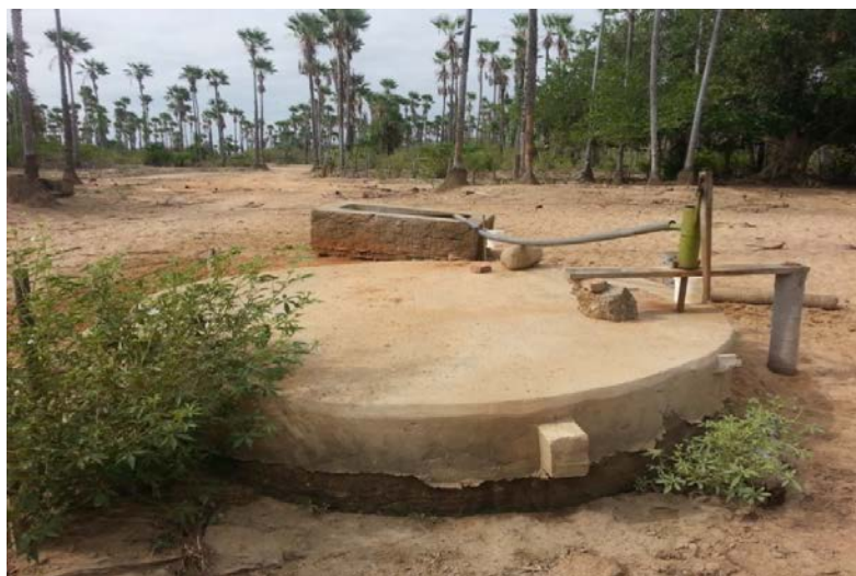
Figura 2. Perfuração de poços artesianos. Fonte: Próprio autor, 2016.
