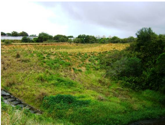
Figura 9. Contenção do banco arenoso com geocélulas. Coord. UTM SAD69 SB25 253648/9349524 (26/09/2017)
