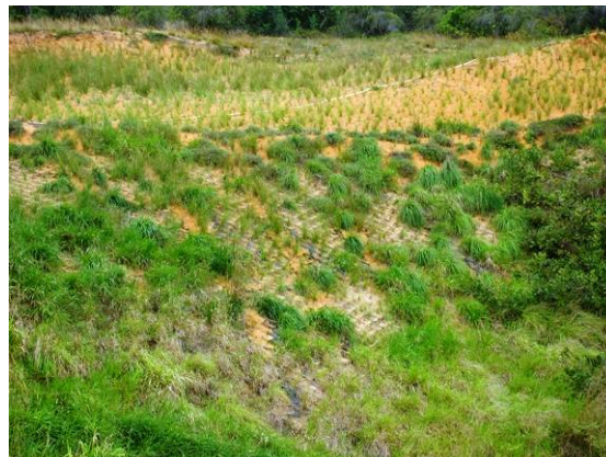
Figura 10. Geocélulas de proteção no banco arenoso foram recuperadas. Coord. UTM SAD69 SB25 253648/9349524 (26/09/2017)
