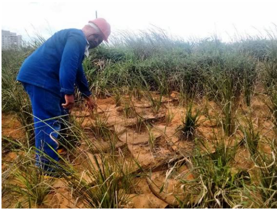
Figura 11. Plantio na área das geocélulas. Coord. UTM SAD69 SB25 253648/9349524 (14/09/2017)
