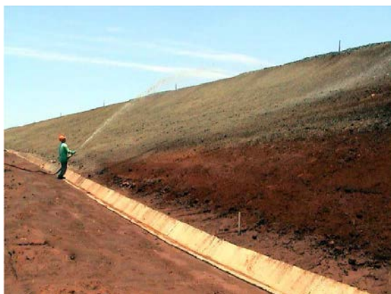
Figura 6: Hidrossemeadura sobre biomanta em talude de aterro (20/05/2011)
