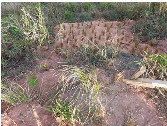
Figura 13. Plantio realizado no talude de aterro junto à via marginal esquerda. Coord. UTM SAD69 SB25 253648/9349524 (28/09/2017)
