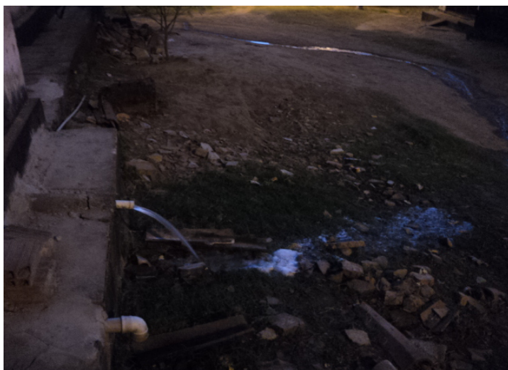
Figura 2. Liberação de efluentes domésticos a céu aberto. Fonte: Autores (2017).
