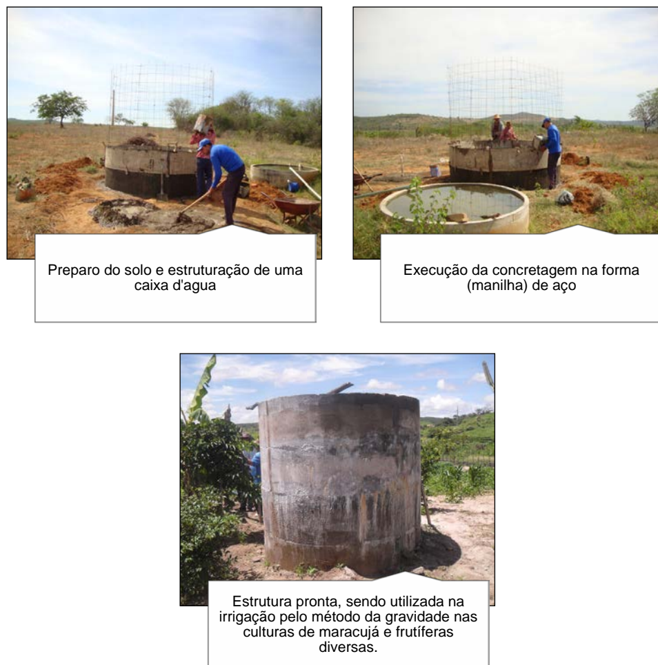
Figura 4. Construção de caixas d'água, Água Branca-PB.
