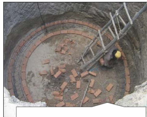
Construção da base do poço ao realizar a execução de anel com estrutura em concreto armado.
