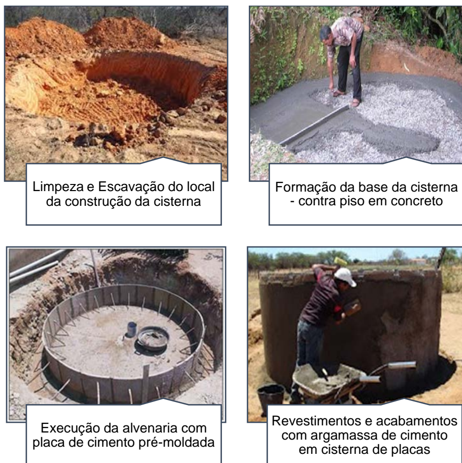
Figura 2. Construção de cisternas, Água Branca-PB.
