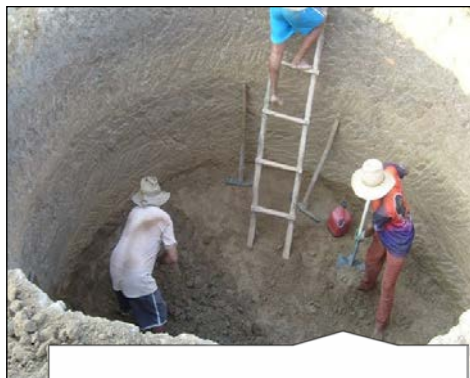
Escavação do poço amazona, utilizando métodos manuais com ferramentas, enxada, pá, picareta, chibanca e alavanca.
