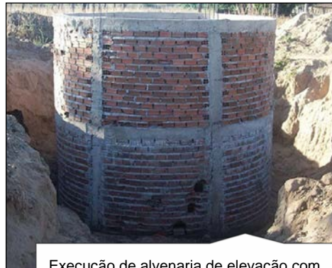
Execução de alvenaria de elevação com blocos cerâmicos, utilizando como amarração pilares e cintas em concreto armado
