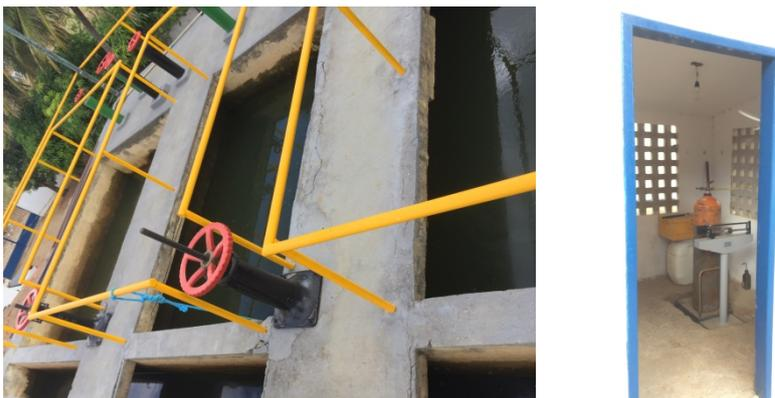
**Figura 6.** Filtração da água em tanques (Esquerda) e recipiente de rmazenamento do Cloro (Direita). Fonte: Autores.
