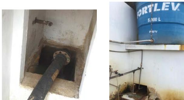
**Figura 5.** Chegada da água bruta à ETA (Esquerda) e local de armazenagem e disposição do Sulfato de Alumínio (Direita). Fonte: Autores.
