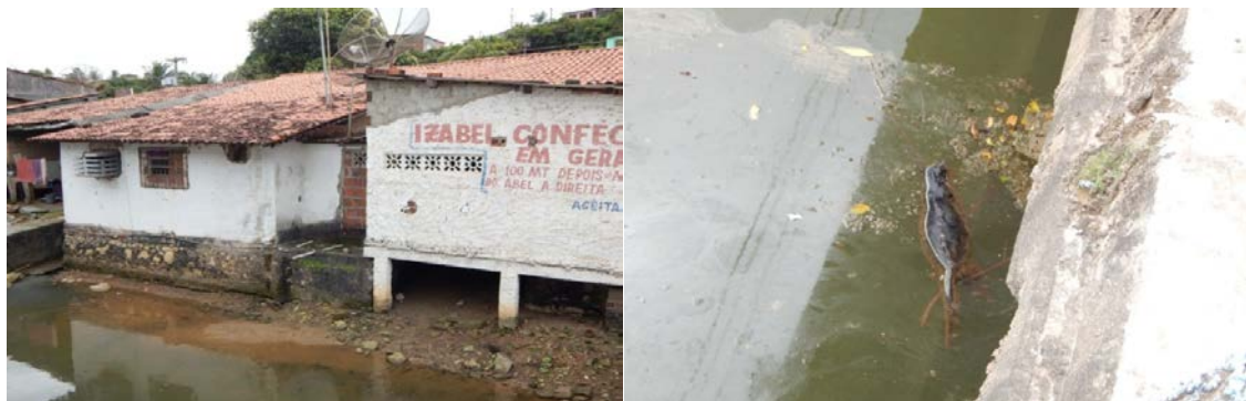
Figura 4. À esquerda, proximidade entre residências e o rio no trecho da ponte e à direita, animal morto (gato) no trecho que compreende a ponte. Fonte: dos próprios autores, 2016.
