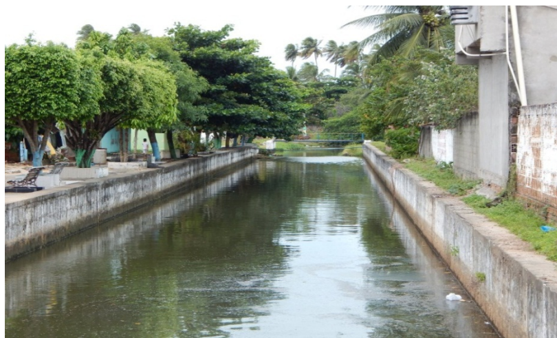
Figura 5. Trecho do rio sob a ponte. Fonte: dos próprios autores, 2016.
