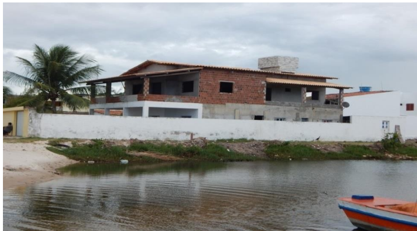
Figura 30. Residência situada ao lado do rio nas mediações de sua foz.
