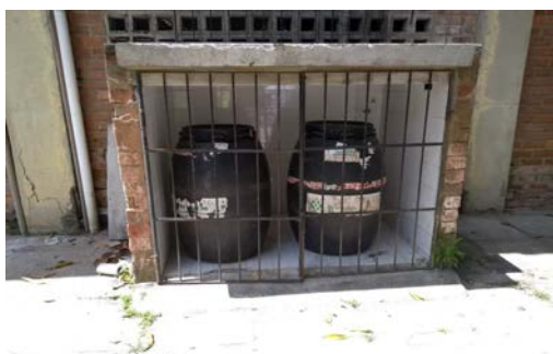
Figura 1. Abrigo de resíduos e recipientes de acondicionamento dos resíduos biológicos e perfurocortantes na UFRPE sede. Fonte: Os autores.
