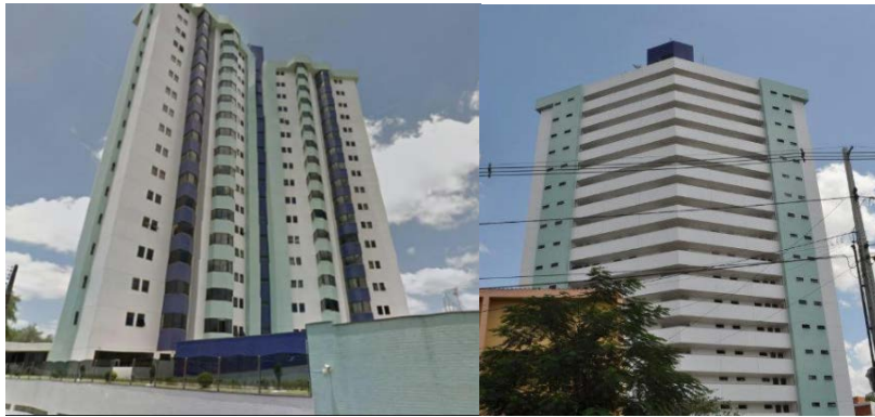
Figura 1. Residencial Porto da Serra.
