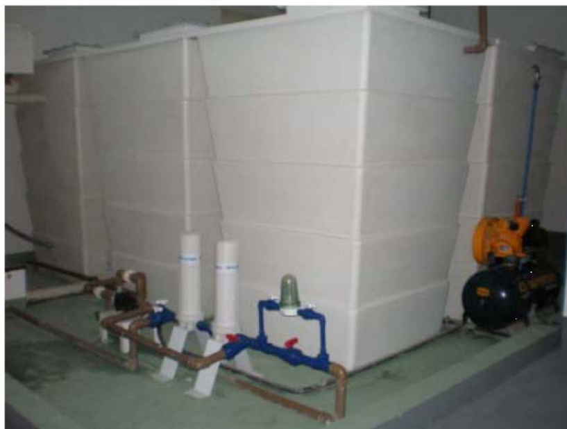
Figura 3. Tanques da ETAC.
