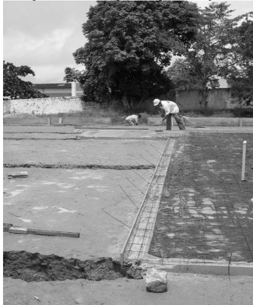
Figura 3. Preparo da fundação e laje de impermeabilização.
