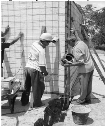
Figura 5. Ajuste e fixação do painel.
