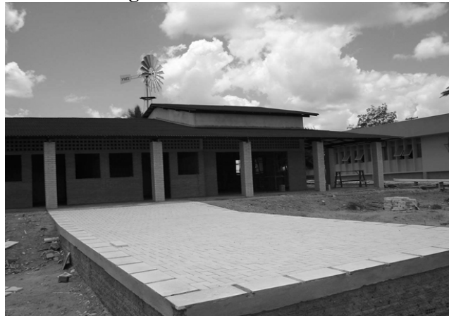
Figura 6. Piso em Ecobloco.
