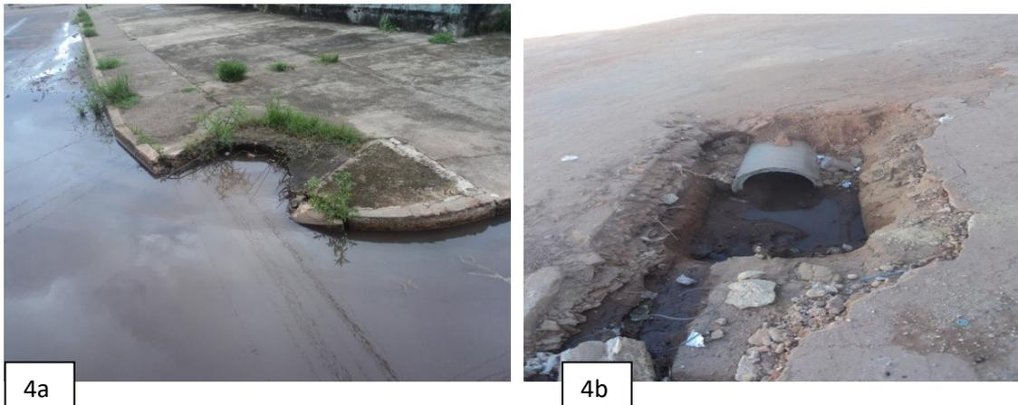
**Figuras 4.** a - Falta de drenagem no bairro do Zerão; b- Falta de drenagem no bairro Novo Horizonte. Fonte: Abreu (2016).
