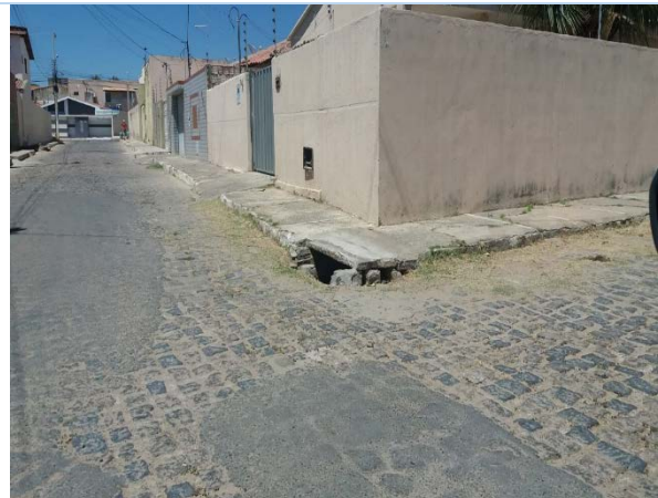
Figura 5. Sarjeta em mau estado de conservação. Fonte: Autor (2018).
