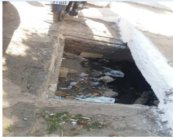
Figura 4. Ponto de drenagem urbana. Fonte: Autor (2018).
